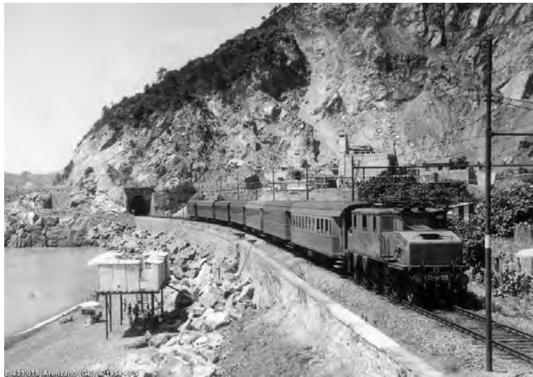
Sopra: La costruzione del rilevato ferroviario per la Genova-Ventimiglia (qui la vecchia sede tra Voltri e Arenzano, dismessa nel 1968) aveva richiesto la sistemazione di una massicciata a difesa della linea stessa per contrastare l'azione erosiva di riflesso durante le mareggiate.
